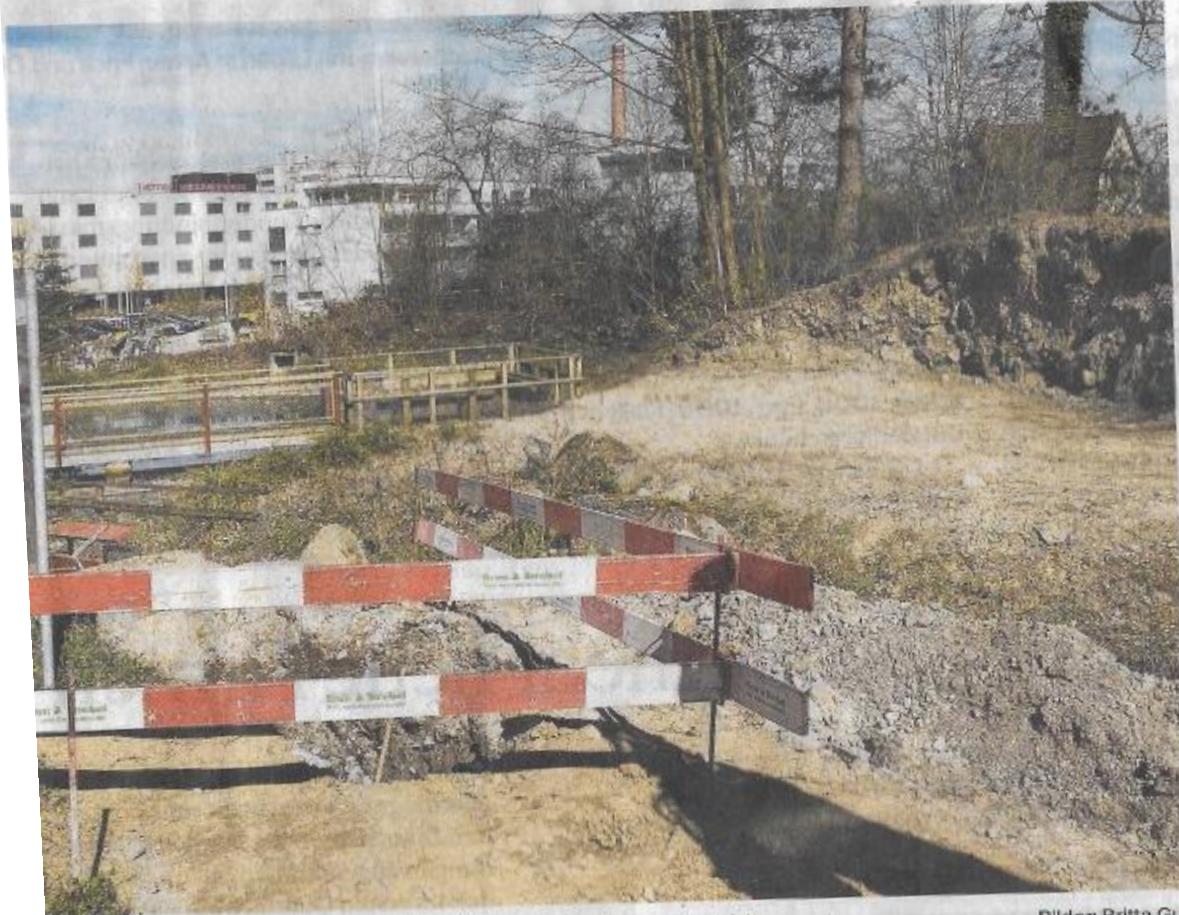
Der erste Aushub für die neue Kneipp-Anlage ist schon gemacht.
